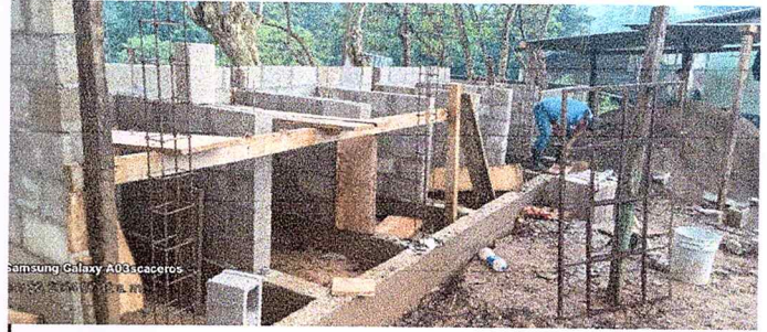
Foto 2: MANTENIMIENTO DE SANITARIOS
